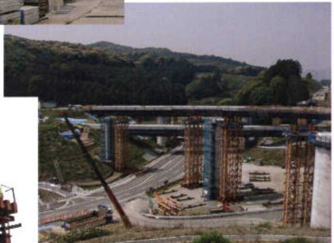
パイプベント材を使用した、 橋梁支保工
