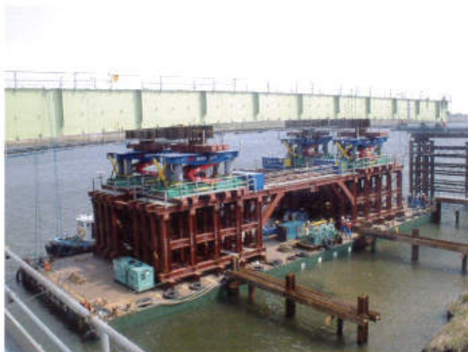
台船上にユニットジャッキを据え付けて橋梁一括架設
