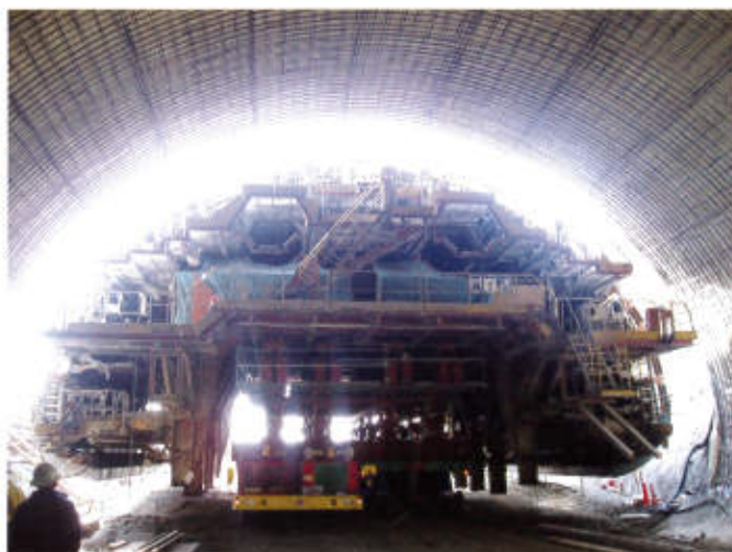
マックスキャリアによるシールドマシン運搬
