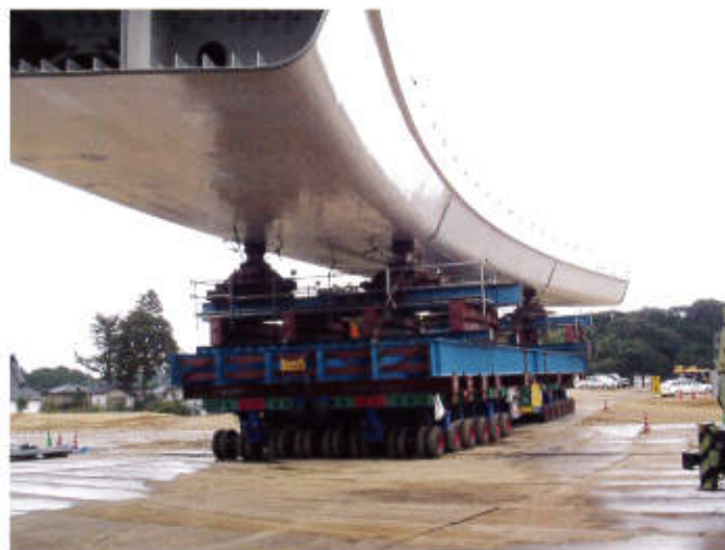
キャリア4台編成による橋梁運搬
