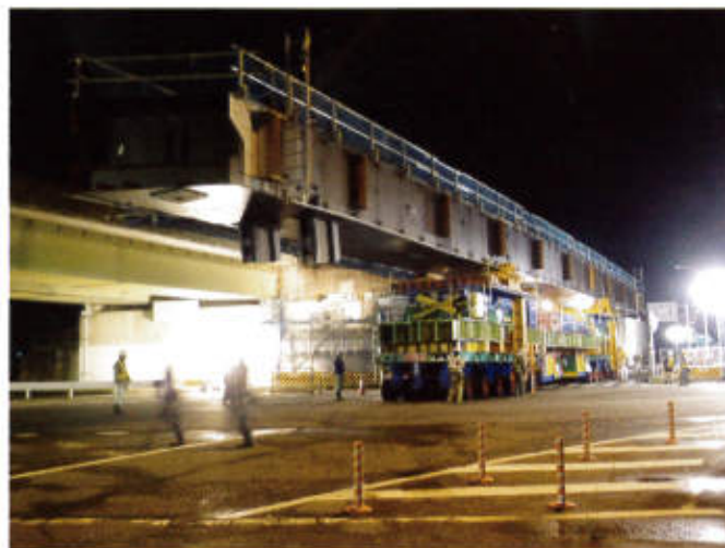
キャリア2台とジャッキ2台の組合せによる橋梁一括架設
