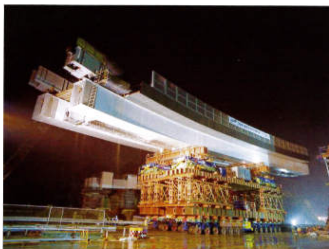
キャリア4台とジャッキ4台の組合せによる橋梁一括架設
