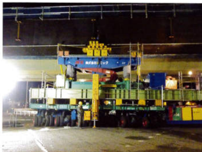
キャリアとジャッキの組合せによる橋梁一括架設
