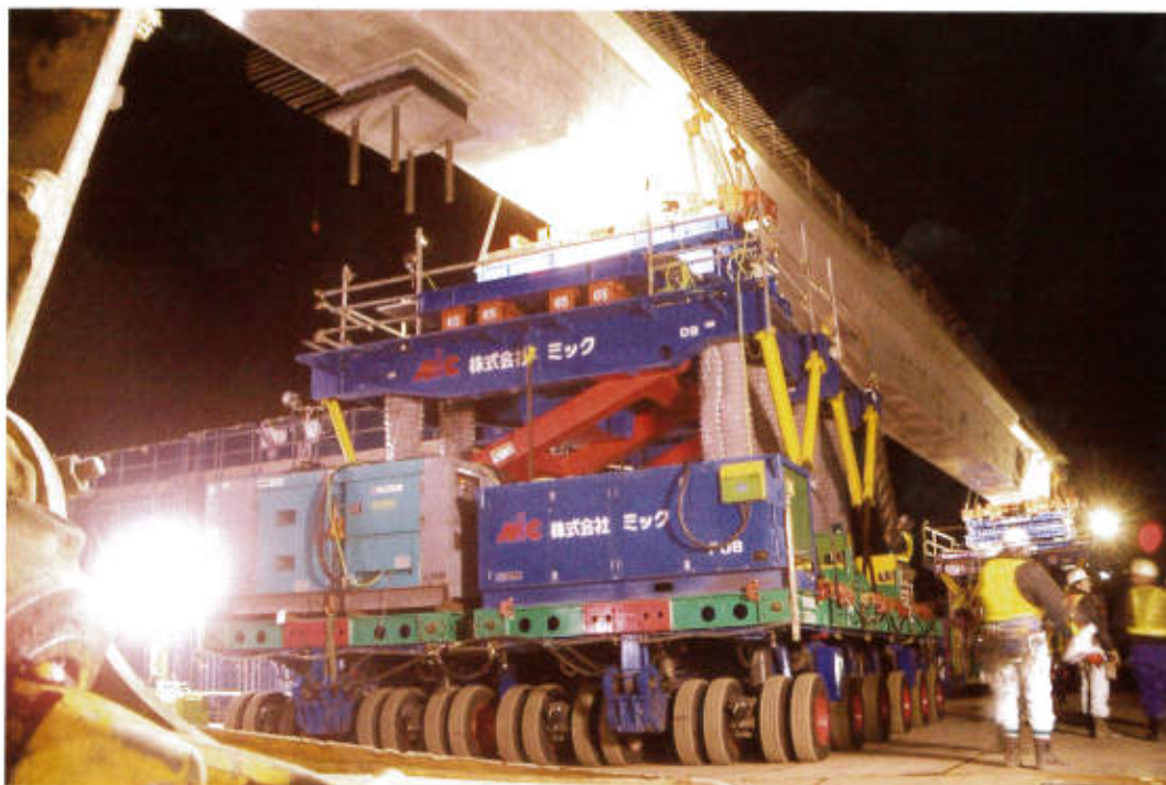
キャリア、ジャッキ、ターンテーブルの組合せによる橋梁一括運搬架設
