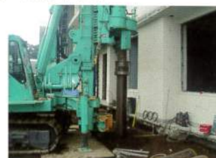
耐震補強工事
