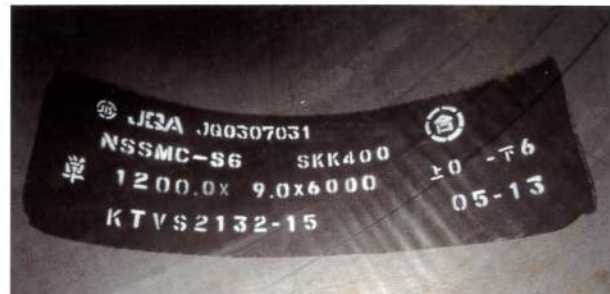
鋼管内面ステンシル表示例
