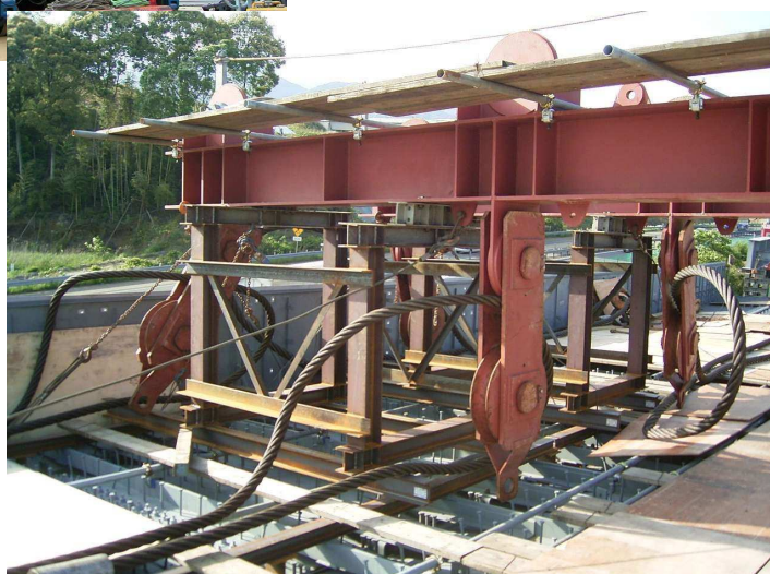
130t平衡滑車を使用した吊天秤
