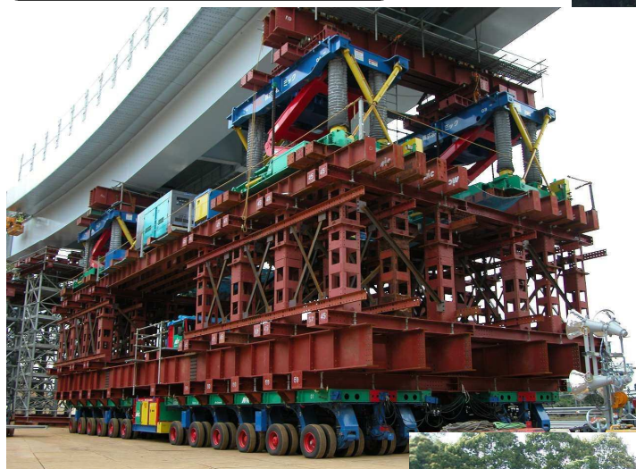
角ベント材と各種梁材を使用した、マックスキャリア架台
