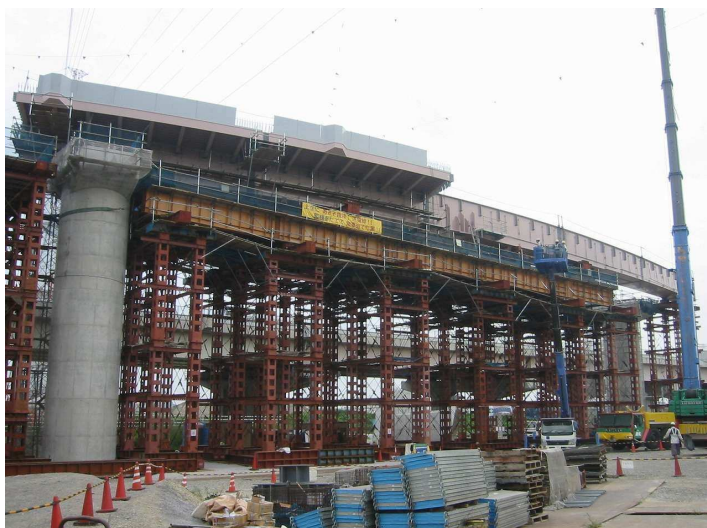
角ベント材と各種梁材を使用した、マックスキャリア架台
